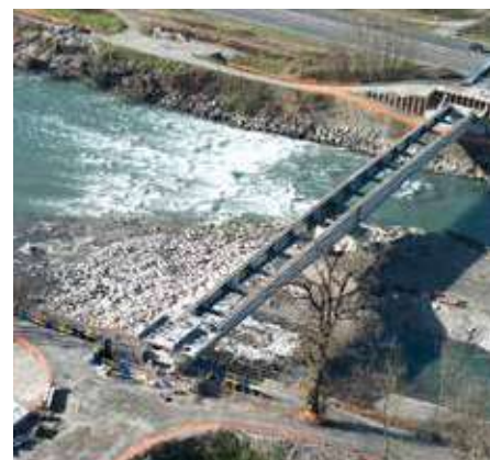
Le chantier du nouveau pont de La Buisnière. Un investissement du Département de 6,2 millions d'euros.
