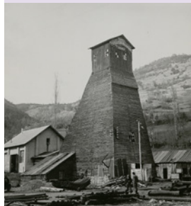
© puits Henry de Reneville à Prunières, Collection Le Boyer, ANMT, 2007_008 04141
